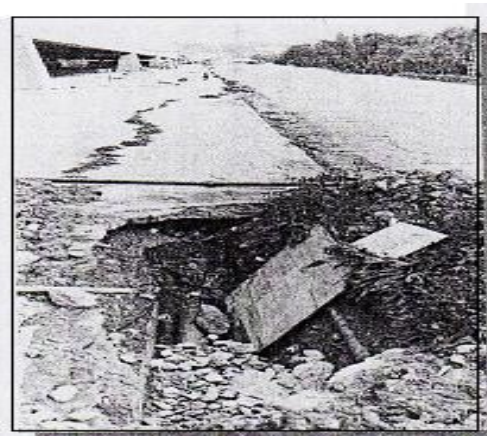
Fig3.2 : Fouille exécutée sur une fuite d'eau du réseau incendie
