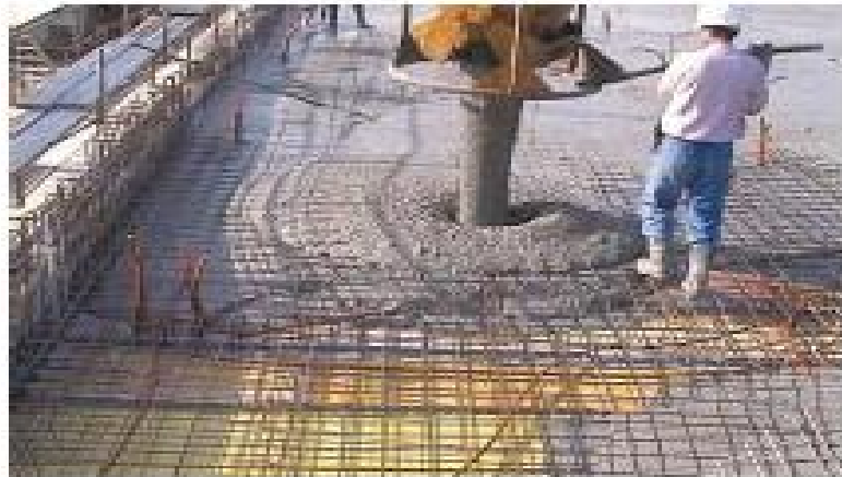
Figure 1.1: Mise en place aisée du béton SCC par un seul ouvrier : au moyen d'une benne dans le cas d'une dalle ou d'une benne munie d'un tube dans le cas d'un mur.
