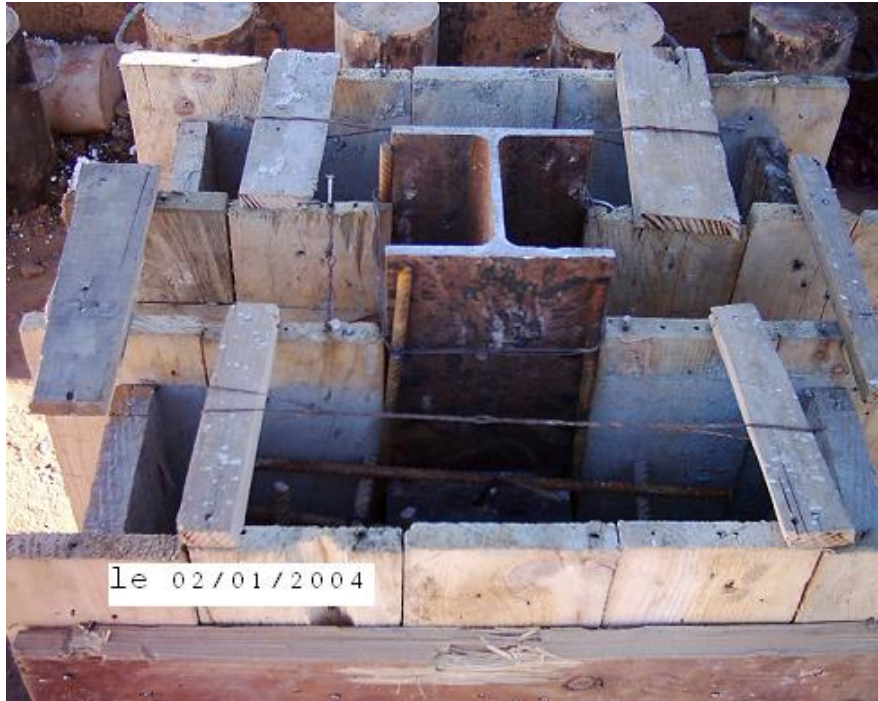
photo 5-10 coffrage et coulage du béton pour le spécimen CC2
