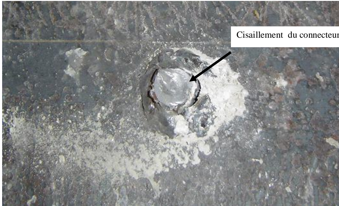
Photo 5-17 :2 ème mode de ruine cisaillement des connecteurs essai push-out du CG 1
