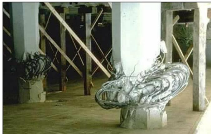
**Fig 1. 4: Endommagement de type compression**
