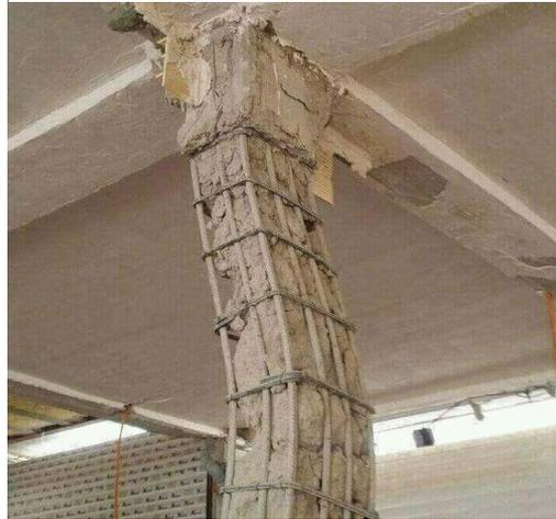
**Fig 1. 3: Endommagement de type flambement**
