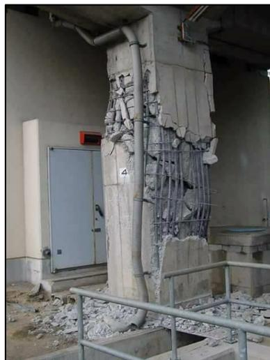
**Fig 1. 2: Endommagement de type cisaillement**
