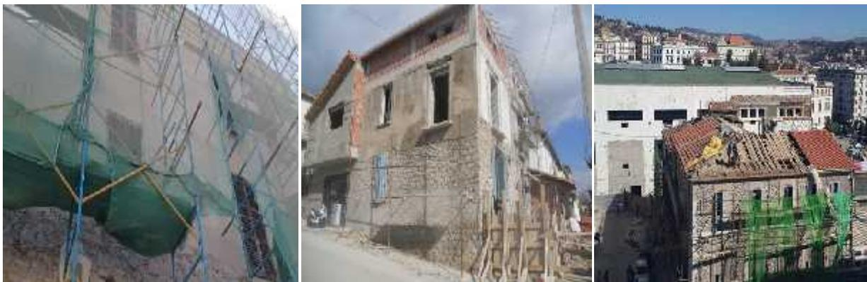
Figure. 3-14 : Typologie constructive en en maçonnerie avec murs porteurs en pierre.
