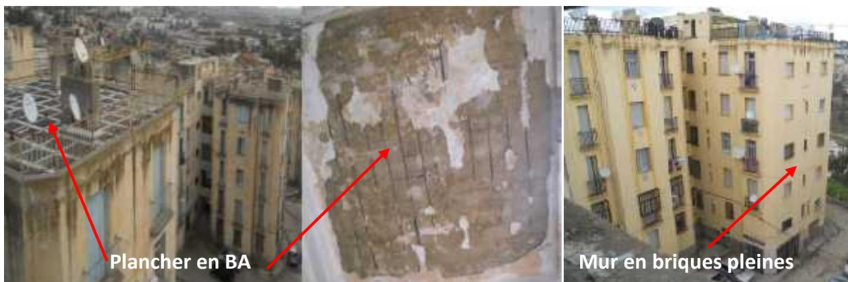
Figure. 3-15 : Photos Constructions en maçonnerie avec murs en briques pleines.
