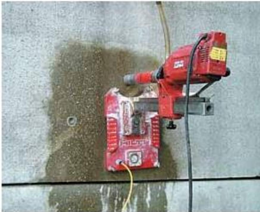
Figure.4.15 : Mise en place d'un carottier à la surface d'une paroi en béton.
