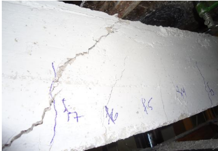
Figure IV.27 : Développement des fissures (rupture par cisaillement) de la poutre P19
