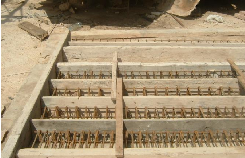
Figure IV.5. Ferrailage des poutres espacement 5cm-7cm-9cm
