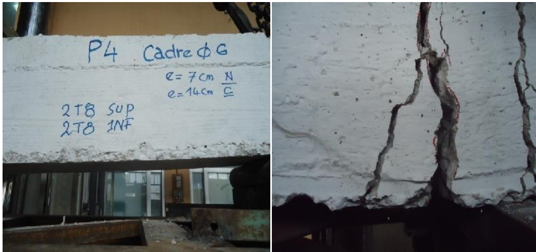
Figure IV.39 : Endommagement de la poutre P4
