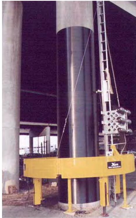
**Figure I.2. 8:** Procédé de l'enroulement filamentaire (Master Builders, Inc. and Structural Preservation Systems 1998, Balaguru et al. 2009)
