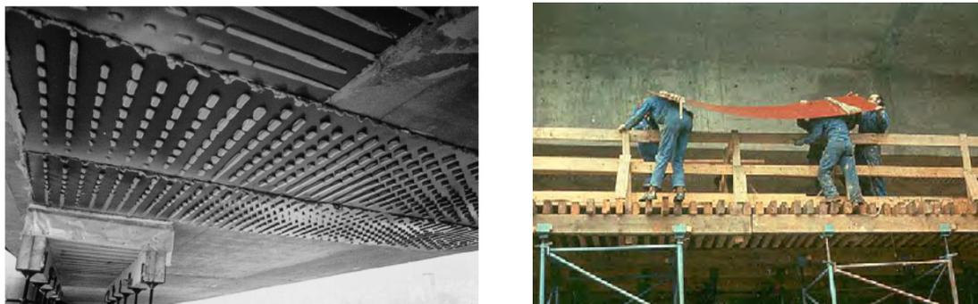
**Figure I.1. 9:** Tôles collées ; (a) difficulté de manutention ; (b) Renforcement du viaduc de Terrenoire par tôles collées perforées -Brevet Freyssinet- (Luyckx 1999)
