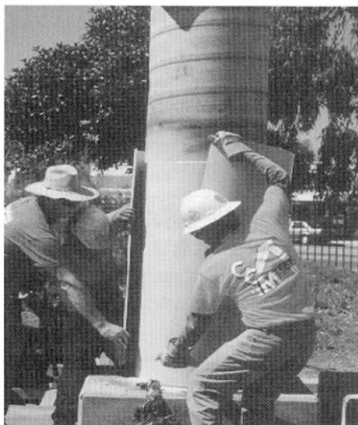
**Figure I.3. 4:** Chemisage par coquille préfabriquée en «PRF» (Monti 2003)
