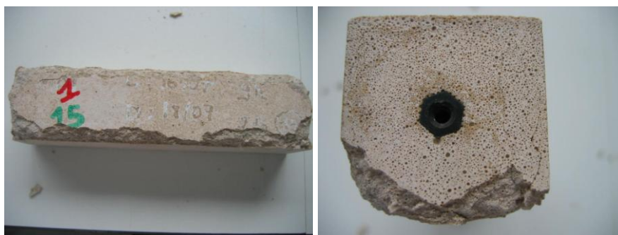
Figure III-28 : Endommagement localisé des mortiers issus des bétons CEMII/59 en Immersion/séchage à 105°C
