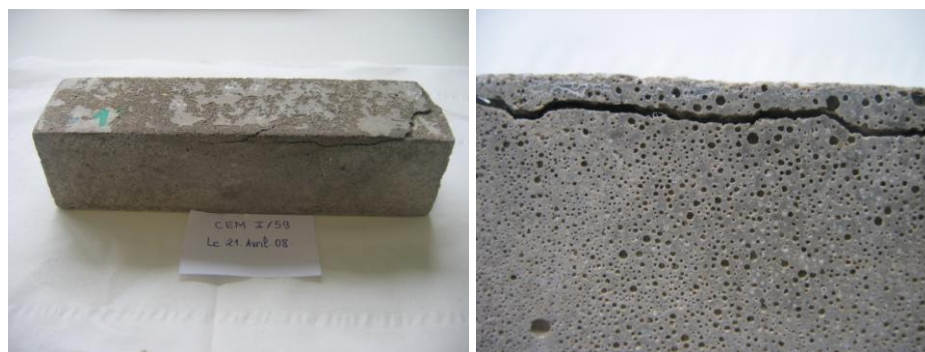
Figure III-41 : Endommagement des mortiers en CEM I/59 Immersion/séchage à 60°C à 6 mois
