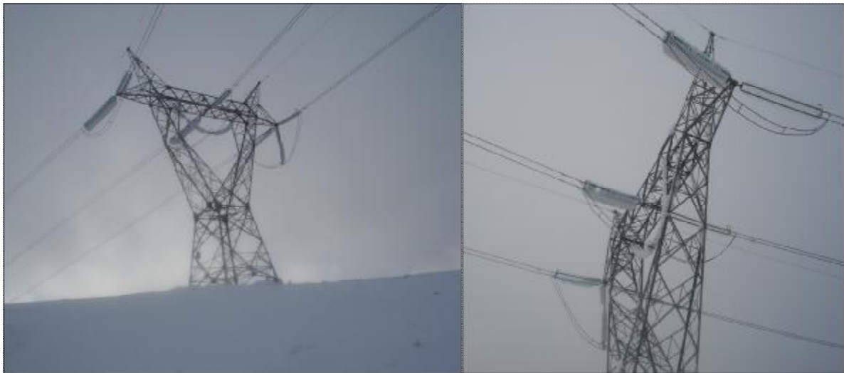
Figure. I.1. Incident enregistré (DRD) le 16 Décembre 2008 à 00h28. (LIGNE 400 kV EL AFFROUN - BIR GHBALOU)
