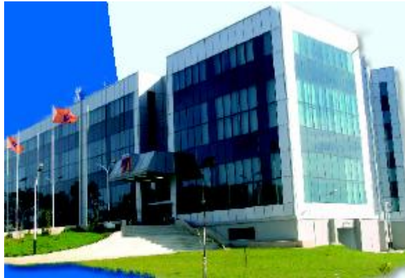
Figure. III.7 Opérateur System Electrique(SONELGAZ), Immeuble des 500 bureaux-Gué de Constantine –Alger
