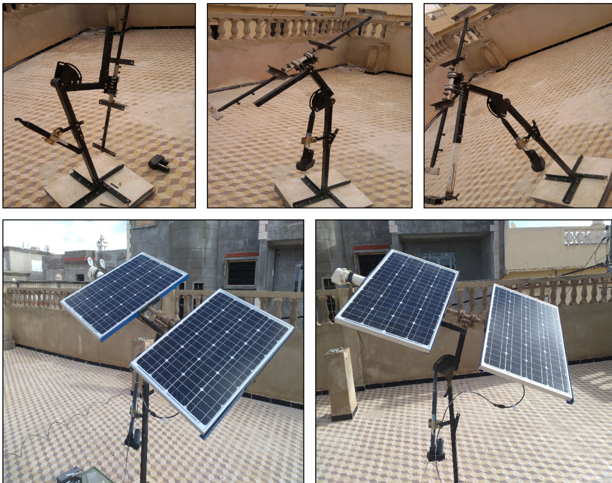
Les différentes phases pour la construction mécanique du support articulé du panneau photovoltaïque concernant le chapitre III.
