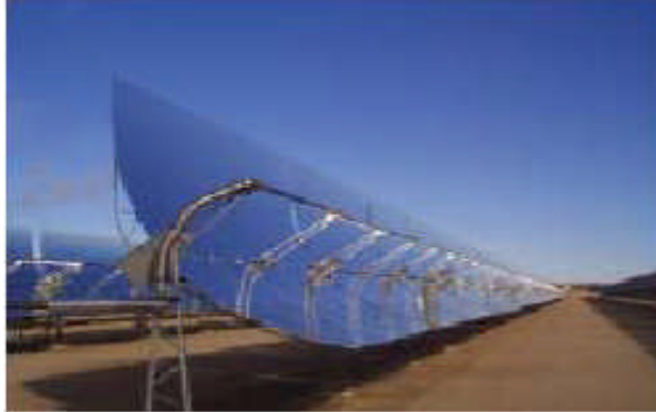
Figure (III.2) : Systèmes à réflecteur cylindro –parabolique
