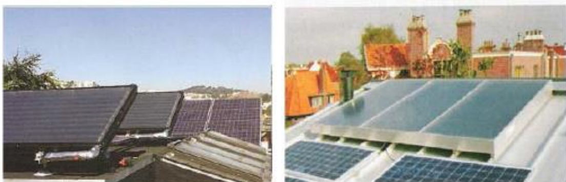
Figure III.3 : Intégrations des capteurs PVT au bâti
