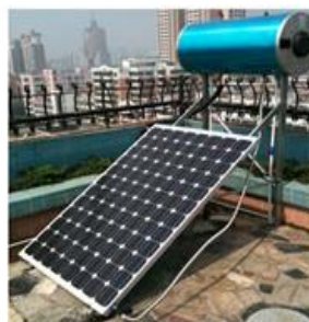
systeme solaire PVT pour le chauffage de l'eau
