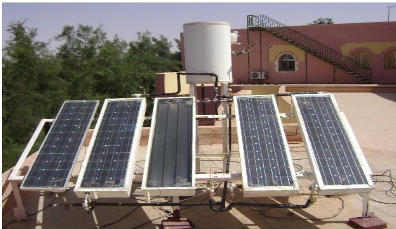
Figure IV.26 : Le banc d'essai de notre réalisation.
