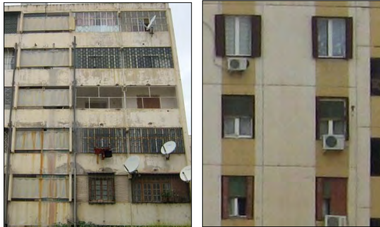
Fig. V. 24 : Protection des espaces vitrés (Source : Auteur)
