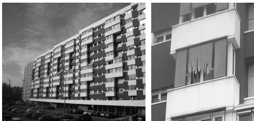
Fig. IV. 4 : Le bloc Libellules dans son état actuel (vue de l'aile sud) et vue d'un balcon transformé. (Source : Camponovo 2006)
