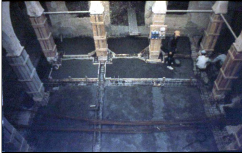
لوحة رقم (7.3): عملية ترميم و تغليف الأعمدة. 169
