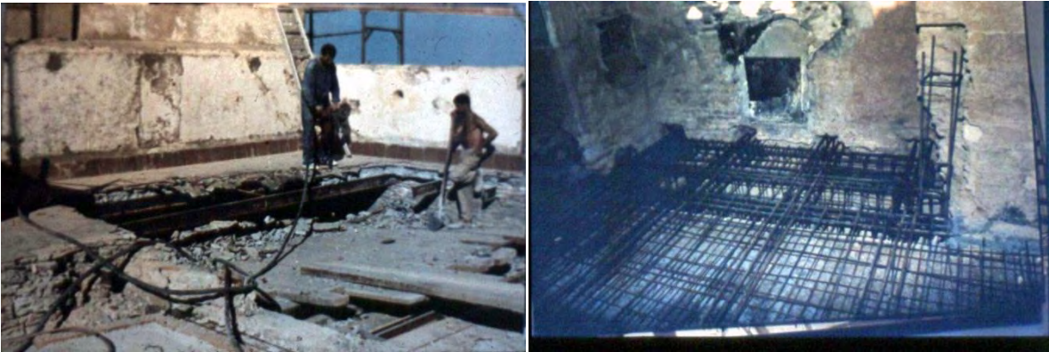
لوحة رقم (9.3): عملية ترميم وإعادة بناء الأرضيات و الأسقف. 171
