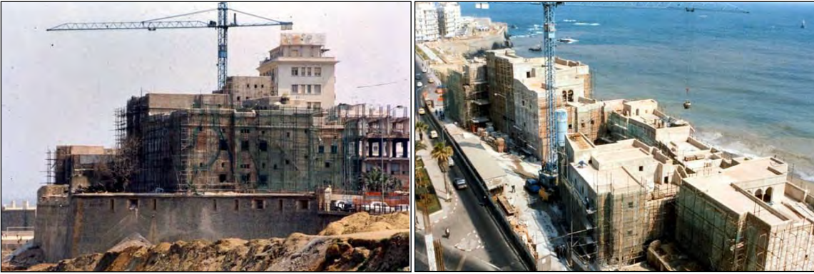
١٦٨. لوحة رقم (6.3): قصر الرياس أثناء عملية الترميم.
