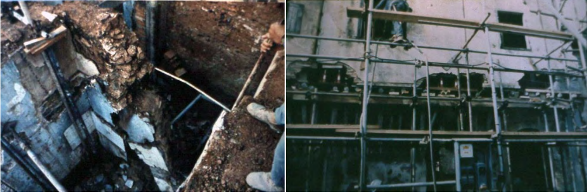
لوحة رقم (8.3): عملية إعادة بناء الجدران المنهارة. 170
