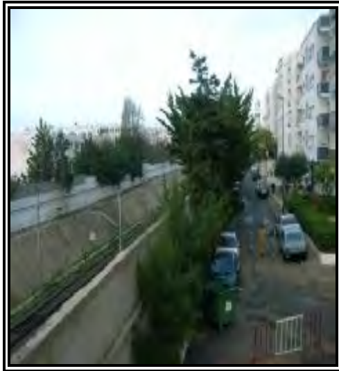
Photo N°XII-1 : 1 er tronçon de la voie ferrée extra muros (1 ère séquence) à couvrir.
