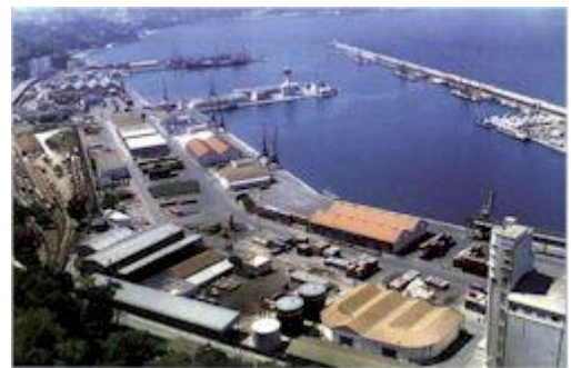
Port de Skikda Photo n° 11
