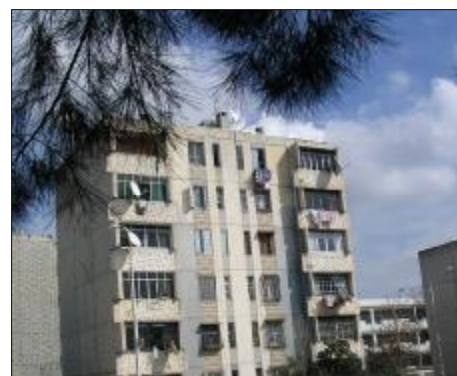
Source : l’auteur, 18.02.2006 PHOTO 5 -22 : une pollution visuelle alarmante
