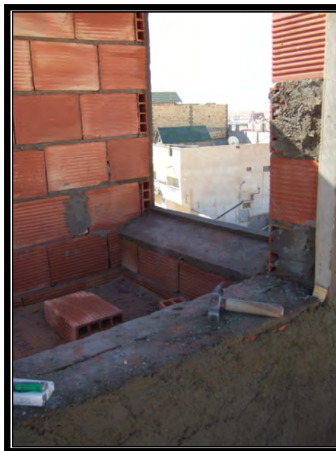
Figure 4.100 : réalisation de la tête de la tour
