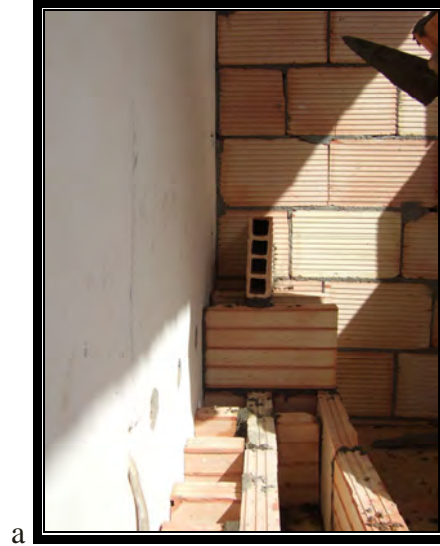
Figure 4.95 : Pose de la première rangée (a,b)
