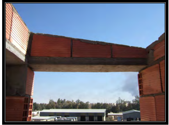
Figure 4.101 : Confection des linteaux et inclinaison de la tête
