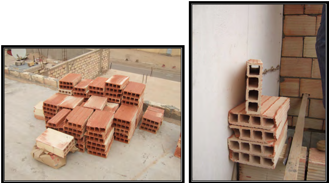
Figure 4.85 : Découpage des Briques
