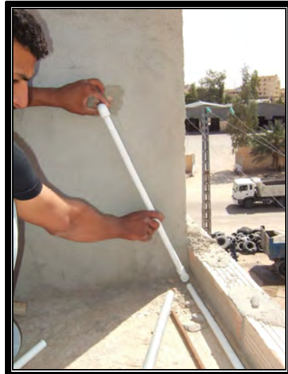
Figure 4.105 : Raccordement du système vers la citerne d'eau (a,b,c)
