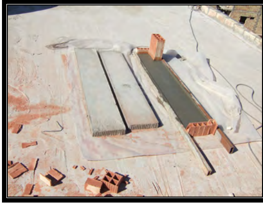
Figure 4.101 : Confection des linteaux et inclinaison de la tête
