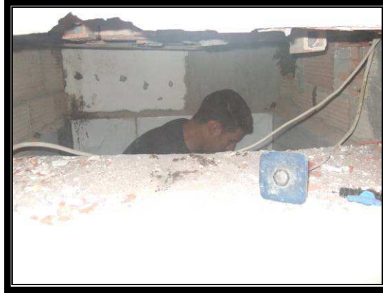
Figure 6.132 : Nettoyage des conduits et récupération du coffrage
