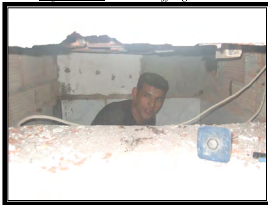
Figure 4.94 : Nettoyage du bassin et récupération du coffrage
