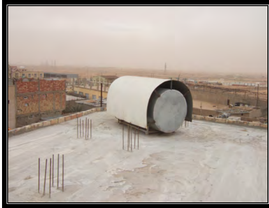
Figure 4.106 : citerne d'eau existante avec double voute ventilé pour protéger l'eau de la citerne contre les rayons solaires
