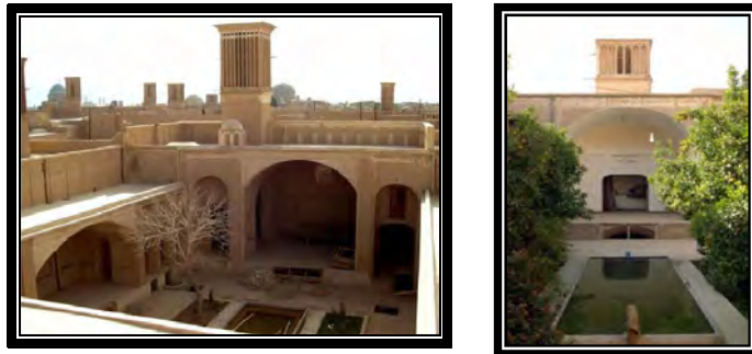
Figure 3.31 : utilisation de l'humidification dans les tours à vent Source Richard-Tolouie 2006.
