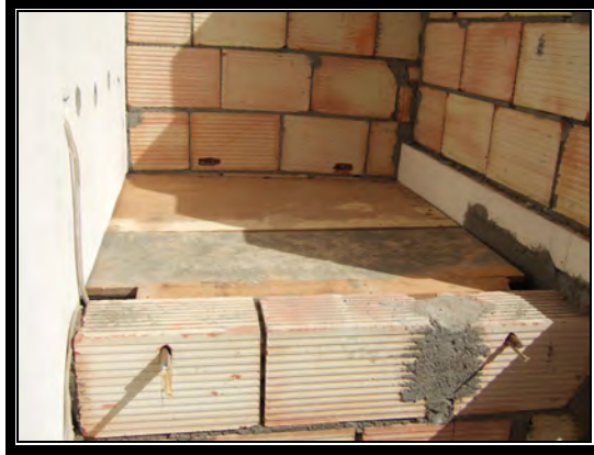
Figure 4.93 Pose du coffrage en bois
