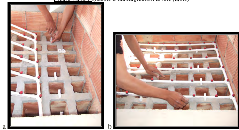
Figure 4.104 : fixation du maillage sur les conduits (a,b)
