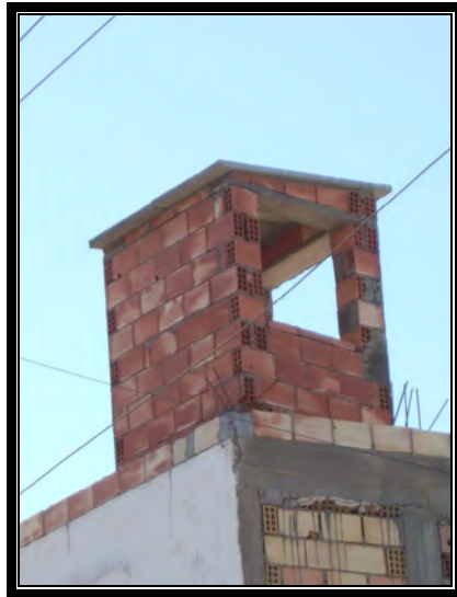
Figure 4.101 : Confection des linteaux et inclinaison de la tête
