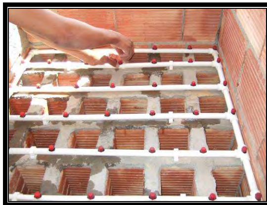
Figure 6.133 : Mise en service du système d'humidification
