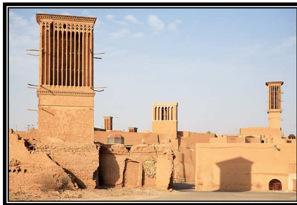
Figure 3.20 : Tour à vent à YAZD, IRAN Source P.S. Ghaemmaghami / M. Mahmoudi , 2005
