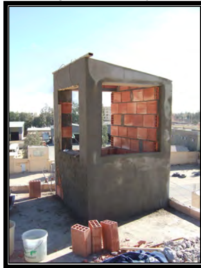
Figure 4.101 : Confection des linteaux et inclinaison de la tête
