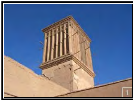
Figure 3.56 : les Tours à vent sont faites de brique de terre crue recouvertes d'un enduit Source P.S. Ghaemmaghami / M. Mahmoudi, 2005
