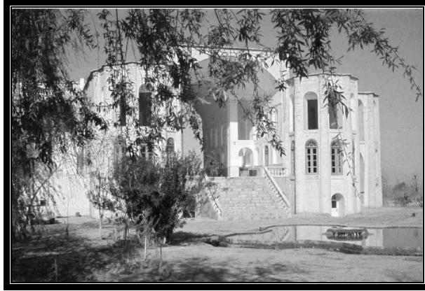
Figure 3.36 : pavillon de Bagh-e khan rafraichissement par ventilation et évaporation rivière sous-terrine Source S. Roaf 2005
