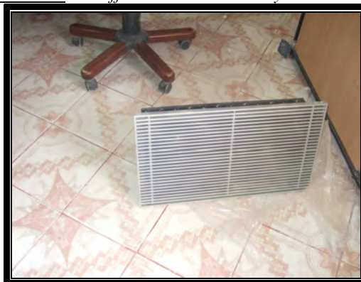
Figure 4.90: Grille en aluminium (Contrôle du débit d'air du soufflage)
