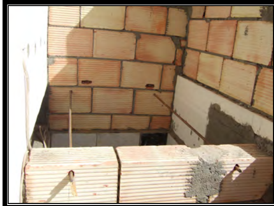
Figure 4.92 : pose des tiges en acier pour supporter les conduits en briques (10x10cm 2 )
