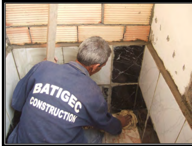
Figure 4.87 : Pose de la dalle de sol à l'intérieur du bassin
