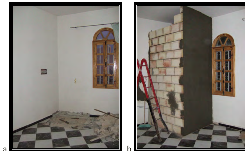
Figure 4.97 : Réalisation de la tour à l'intérieur du studio (a : préparation du sol, b : construction de la tour)
