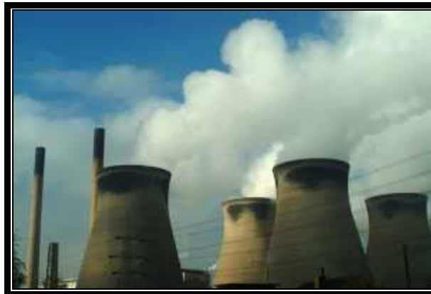
Figure 2.17 : Emission de chaleur anthropique- tours de refroidissement Source : www.freefoto.com
