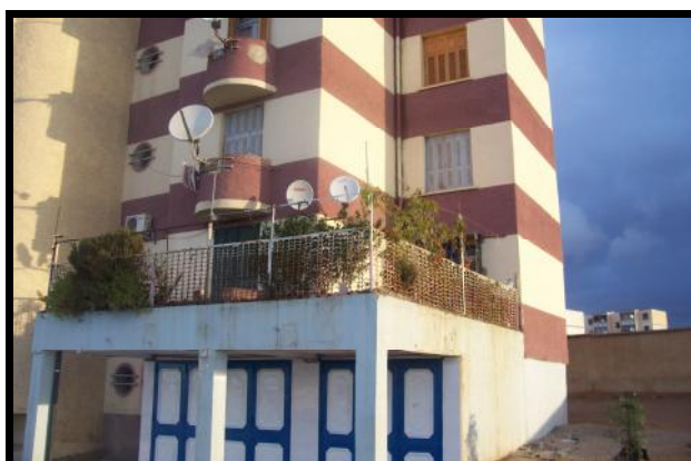
Figure 1.3 Transformations de terrasses inaccessibles en lieu d'agrément et d'étalage du linge.
