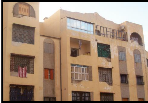
Figure 1.8 Différents types de fermetures de balcons dictées par le besoin de sécurité, d'intimité et d'agrandissement de l'espace. Constantine. Source auteur.
