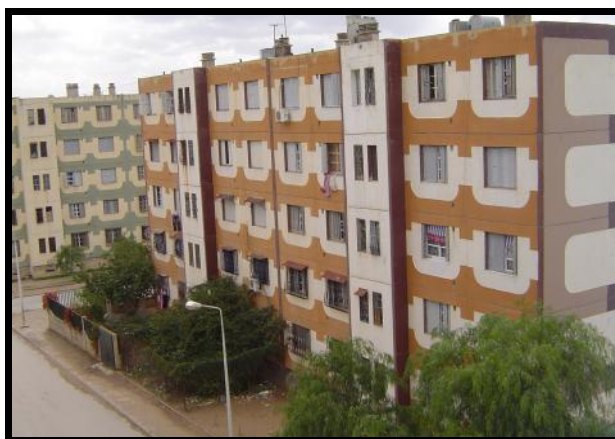
Figure1.5 Aménagement de terrains entourant les immeubles en jardins à Constantine. (auteur).
