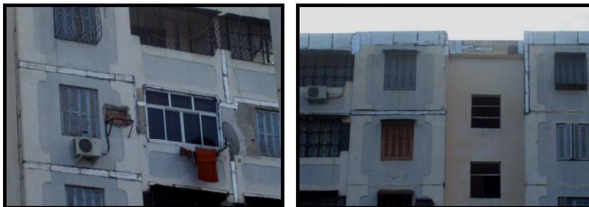
Figure 6.12 Correction des ponts thermiques au niveau des liaisons entre panneaux par les usagers des logements du site d'investigation
