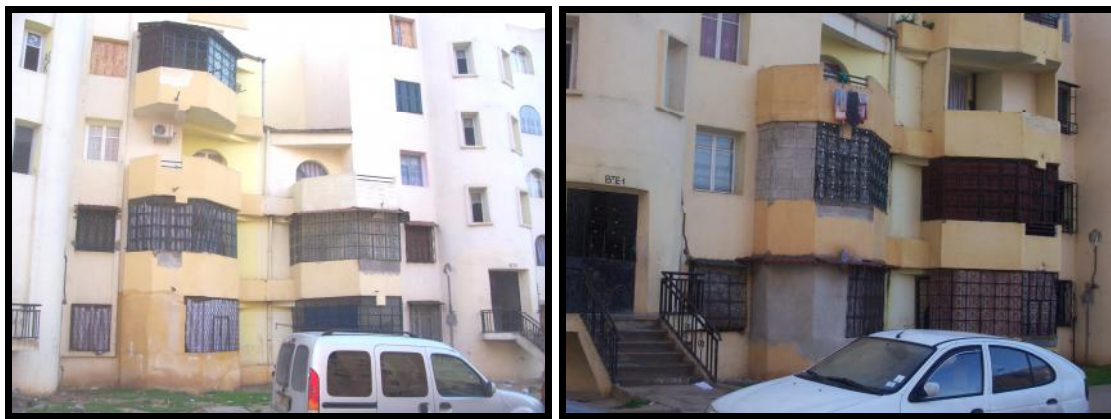
Figure 1.7 Fermeture de balcons en réponse à une recherche d'intimité par les locataires du rez-de-chaussée. Constantine. (auteur).
