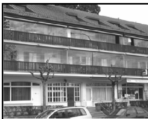
Figure 1.12 Intervention étatique. Couverture des balcons d'un bâtiment du 20 ème siècle par vitrage. Genève (R.Camponovo, 2006 3 )
