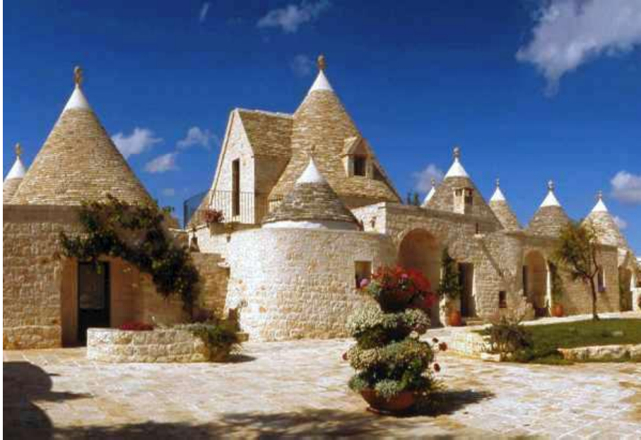
Figure I. 8 : Vue des tours dans un hôtel en Italie construits récemment
