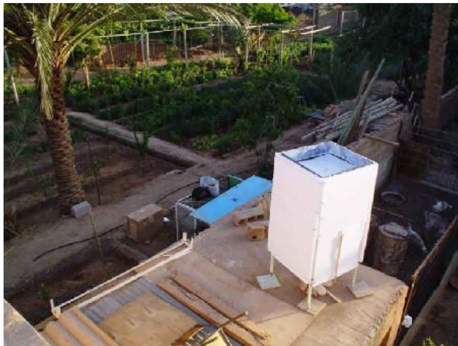
Photo V. 8 : Vue de la cellule (A) montrant la toiture avec le système de refroidissement.
