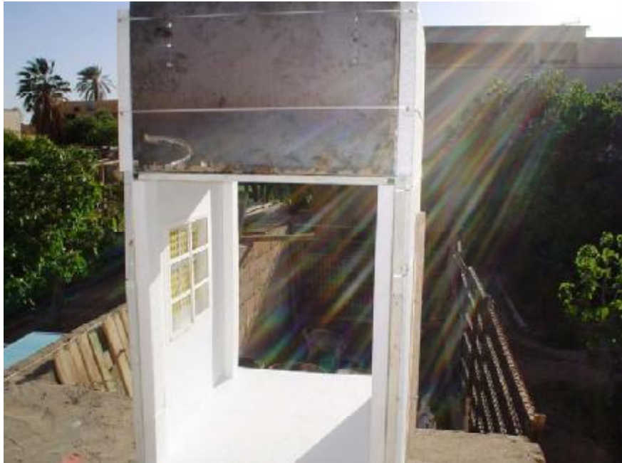
Photo V. 2 : Vue sur l'intérieure de la Cellule en période de réalisation.
