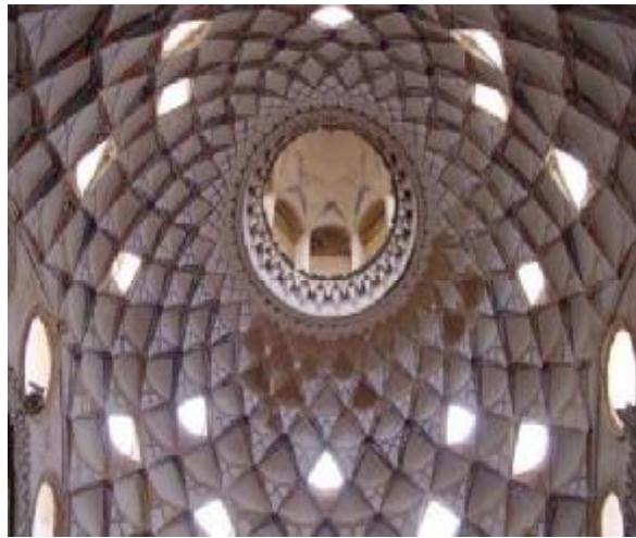
Figure I. 23 : Dôme de Khan Borujerd en Iran, ayant au sommet des ouvertures
