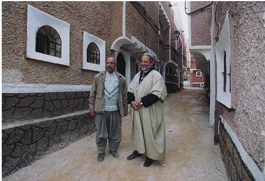
Figure I. 15 : Percement de façade des maisons à Ghardaïa en Algérie Source : http://algerieghardaia.afrikblog.com/albums/ghardia (2004).
