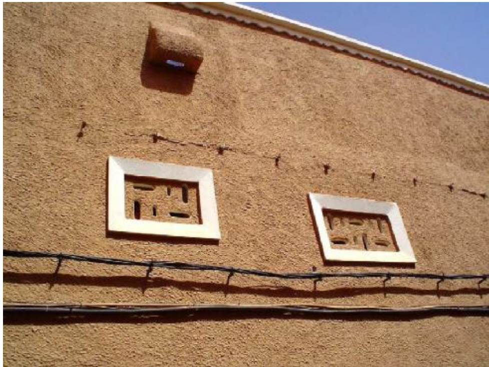
Figure I. 16 : Détail d'une fenêtre à Béni-Izguen, Ghardaïa Source : L'auteur (2004)
