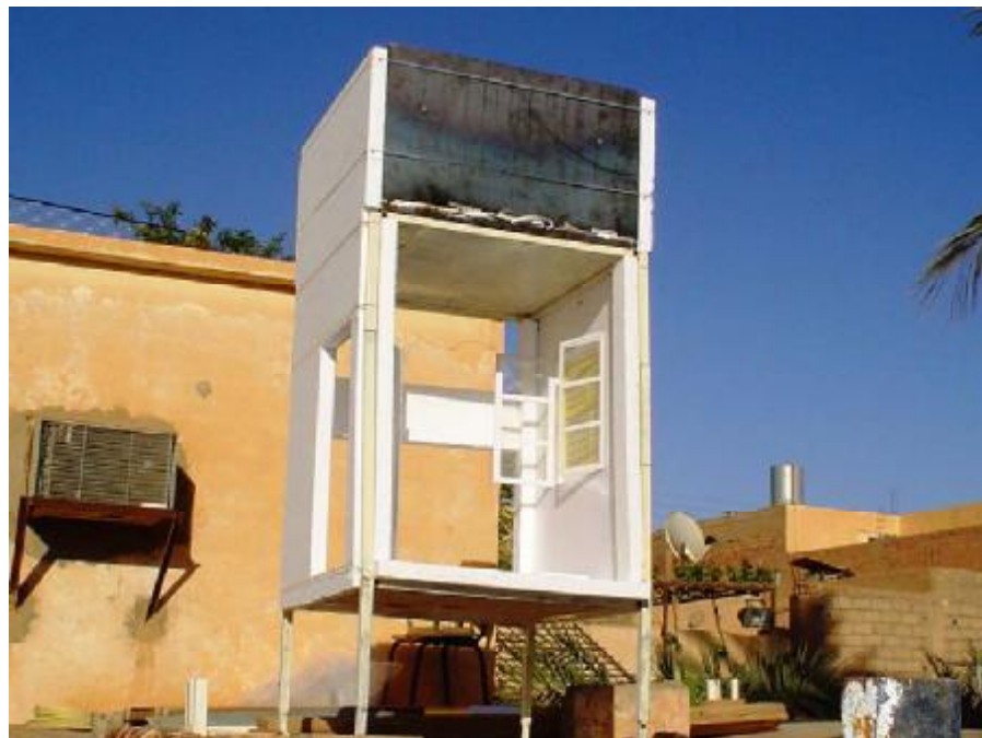
Photo V. 5 : Vue montrant les ouvertures (porte et fenêtre) de la cellule en période de réalisation
