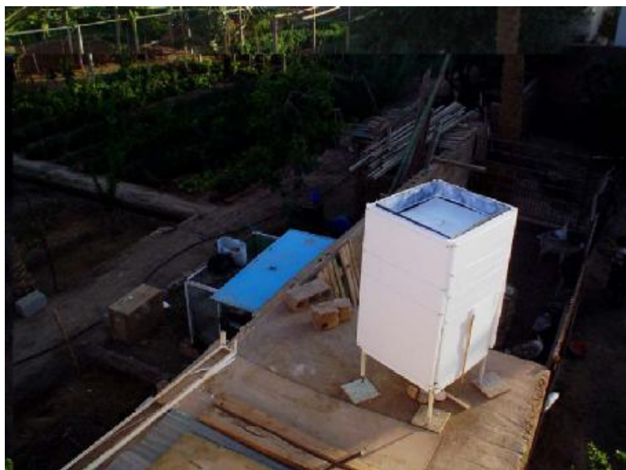
Photo V. 9 : La toiture sans le système de refroidissement cellule (B).
