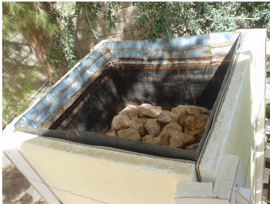
Photo V. 11 : Vue montrant la toiture avec le système de refroidissement ouvert..
