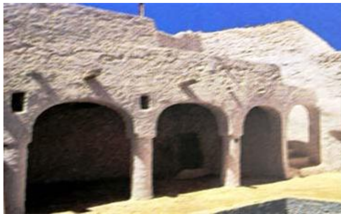
Figure I. 18 : Pièce commandée par un Iqomar à Ghardaïa. Source : Ravereau [3], p.100
