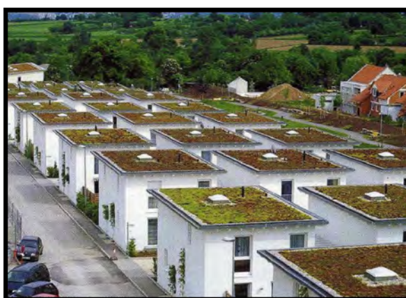
Figure 8: Multiplication des toits végétalisés comme moyen de réduction de l'effet d'ICU (Source : Leroux.F, 2005)
