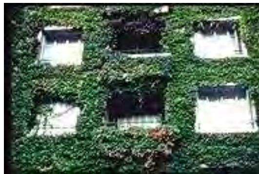
Figure III-9: Traitement de la façade OUEST (Source : www.arbreurbain.com )
