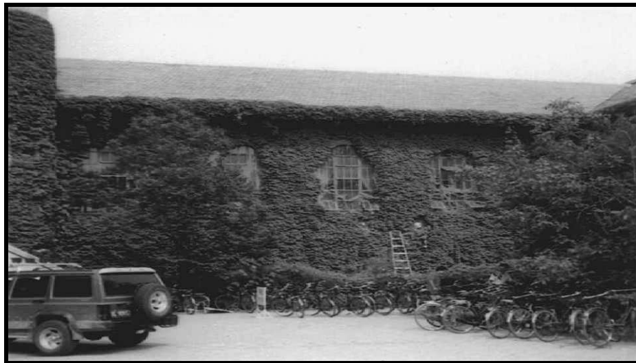
Figure IV-5: Vue Ouest de la bibliothèque d'université de Tsinghua
