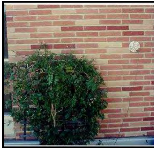
Figure IV-12: Vigne de Campsis sur un mur sud de brique (Source : SANDIFER et GIVONI 2002)
