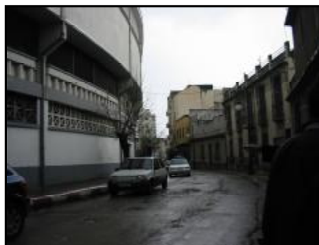
Figure N° 25 : Etat actuel de l'avenue Boumedous au niveau du stade
