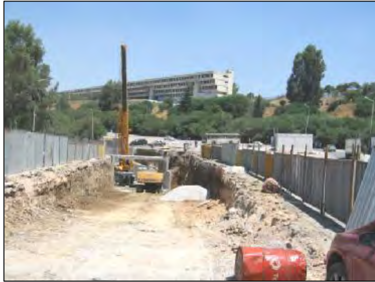
Travaux pour réaliser la trémie de la cité universitaire 8/11/71 (Photo de l'auteur, mai 2006)
