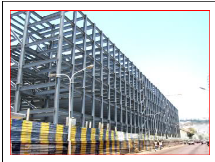
la structure du parking à cinq étages, en construction, sur l'Avenue Zaâ mouche. (Photo de l'auteur, sept 2005)
