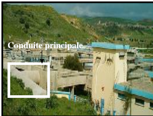
Photo n°1 : Conduite principale des eaux usées qui alimente la station
