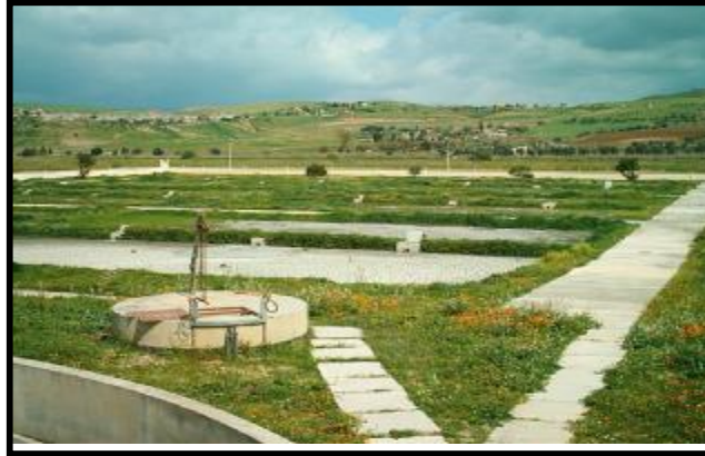
Photo n°8 : Lits de séchage des boues
