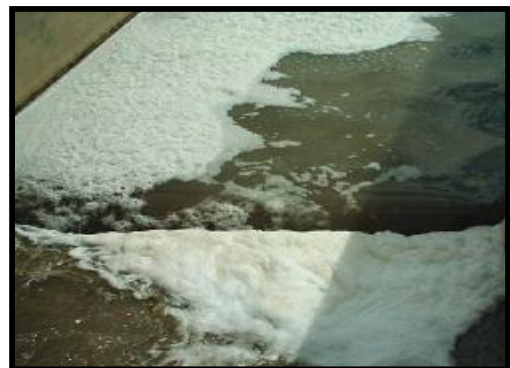
Photo n°2 : eaux usées brutes entrant dans la station
