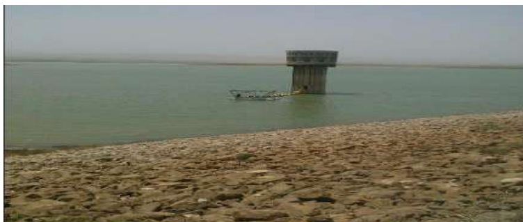
Figure 37 : Photo de la station KM3 dans le barrage KM (prise par l'auteur, 2013)
