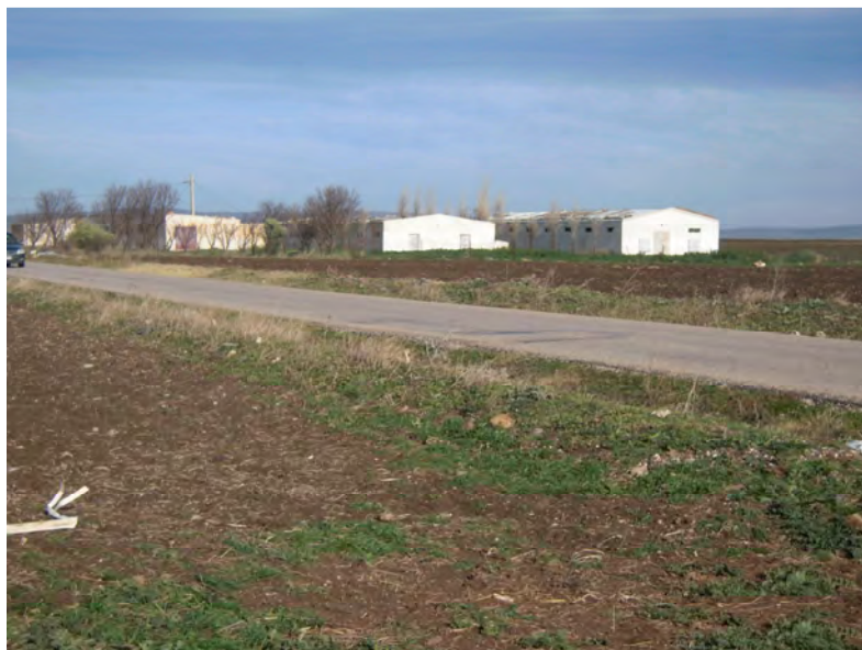
Figure 3 : Bâtiment en béton à proximité de la route
