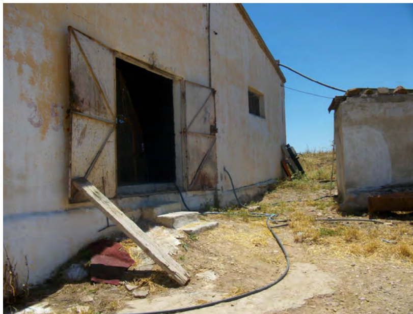
Figure 19 : Bâtiment sans pédiluve
