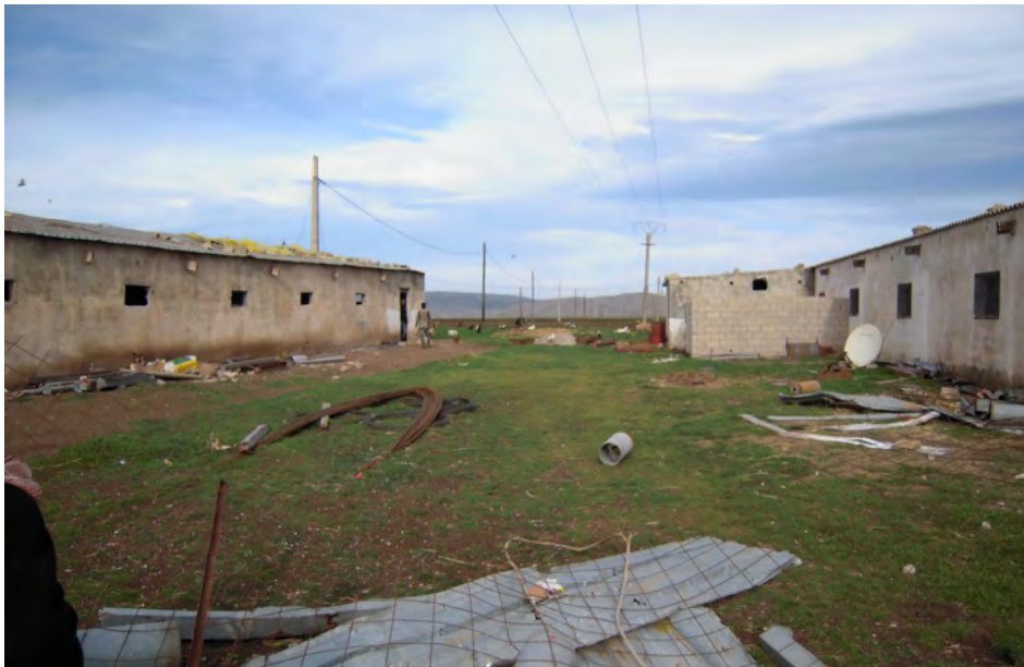
Figures 27 : Abords des bâtiments
