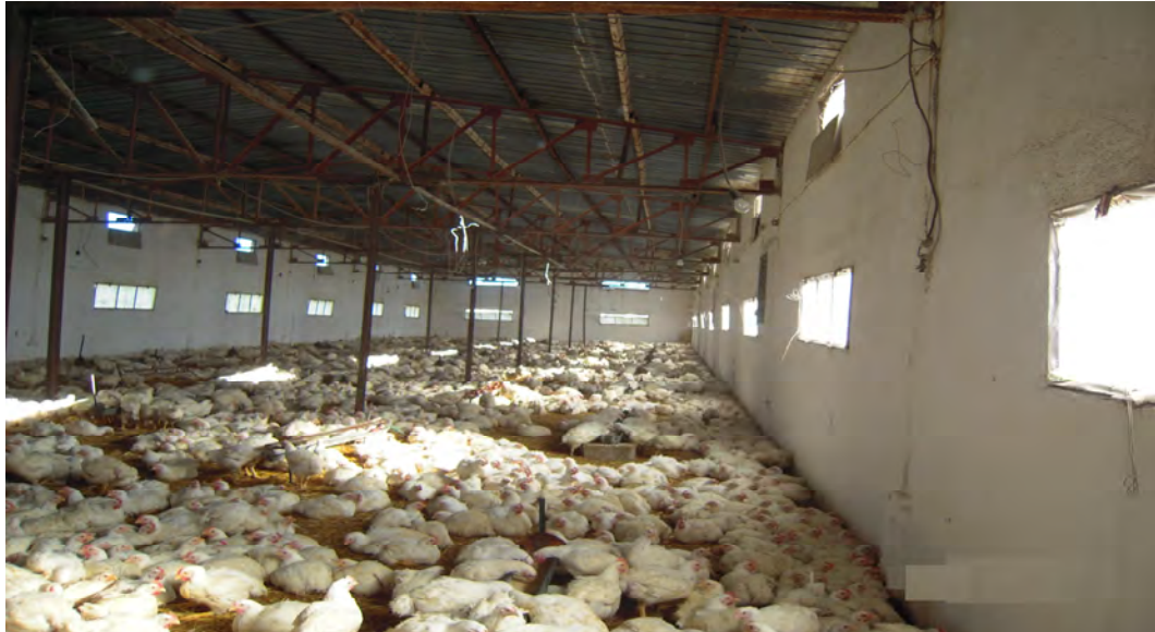
Figure 6 : Ouvertures non-conformes sur les murs d'un bâtiment de poulets de chair. Animaux contre les murs fuyant les rayons solaires
