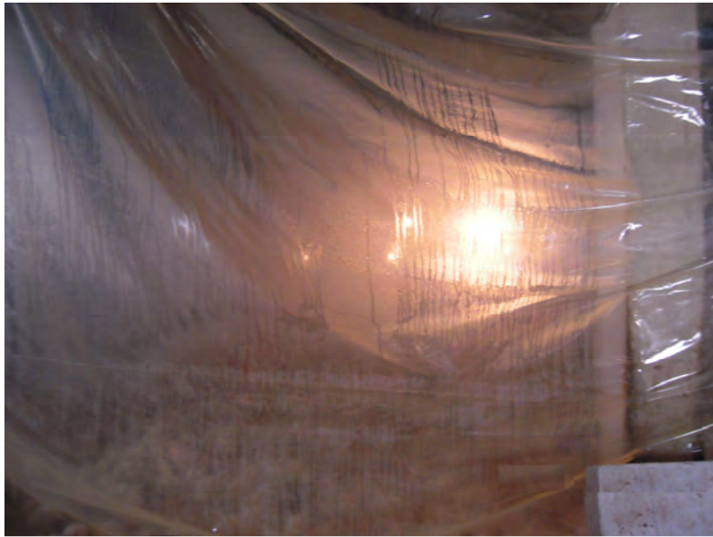
Figure 15: Condensation de l'humidité sur le film plastique séparant l'entrée et l'aire de vie des animaux
