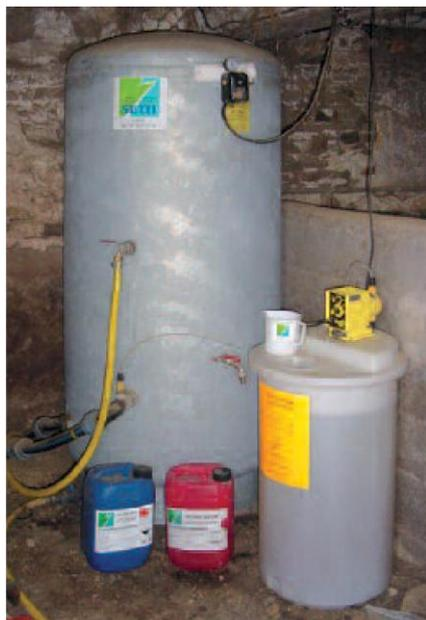
**Figure7** : Traitement de désinfection Permanente + une cuve d'eau (Itavie, 2010)
