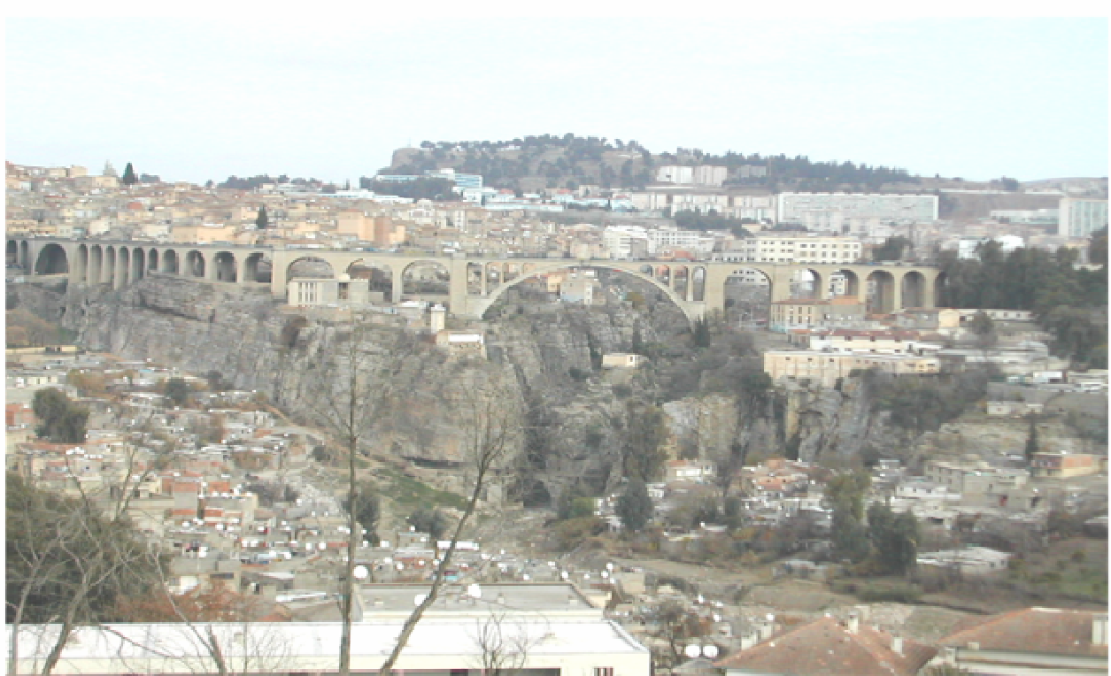
الصورة رقم: (09) جسر سيدي راشد
