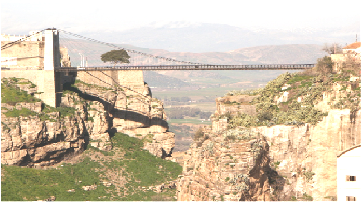
الصورة رقم: (10) جسر سيدي مسيد
