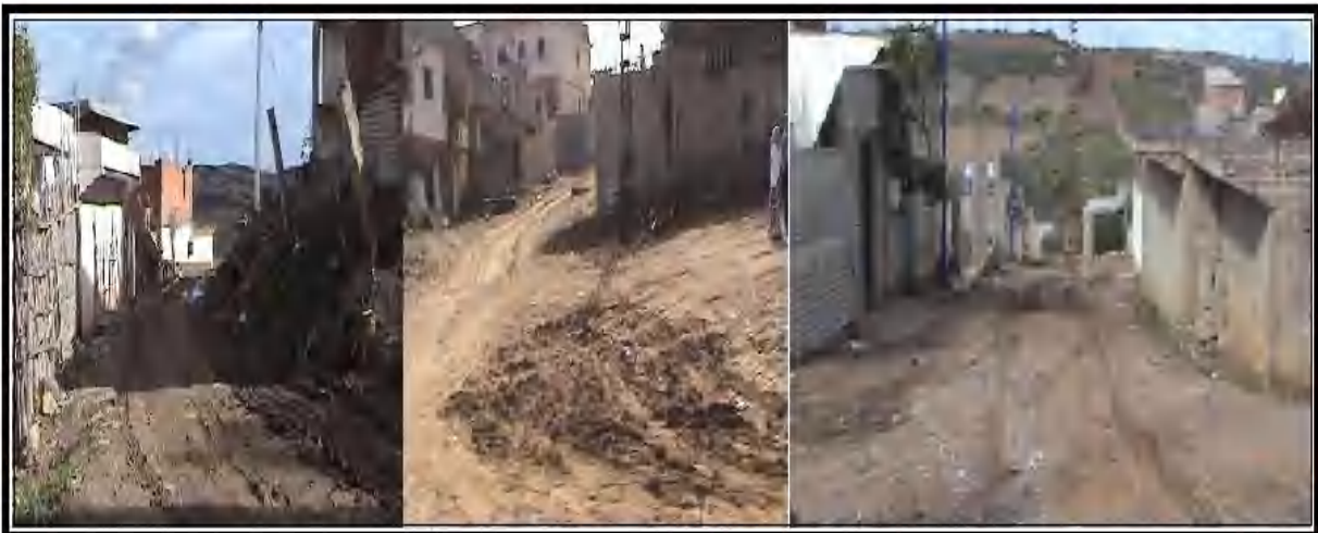
صورة رقم 56: تعكس حالة الطرقات الداخلية مركز واد القصب التقطت من طرف الباحثة في فيفري 2017.
