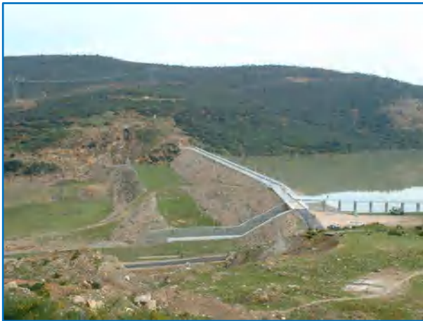
Photo 12 : Digue et évacuateur de crue du barrage de Mexa. (ANBT Mexa, 2017).
