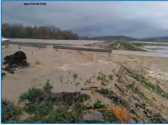
Photo 34: Surverse de la digue 6, l'eau coule vers les terres agricoles du côté du pont de la route reliant (El Tarf -Ain Khiar). (DRE, 2015).
