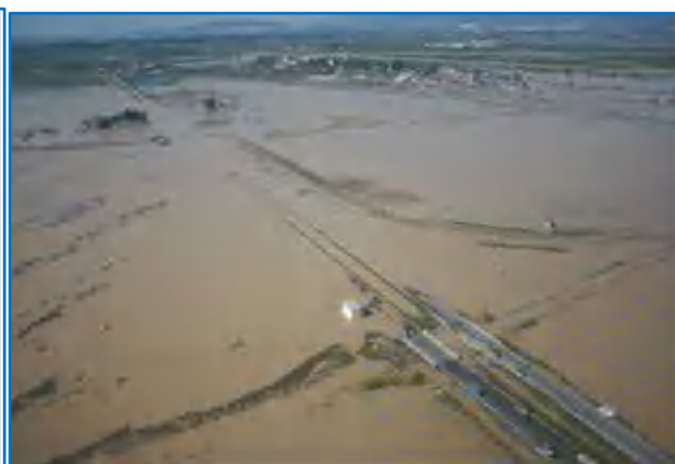
Photo 8: Inondation du nouvel aéroport d'Annaba vers la commune d'Echatt (RN84A) (Wilaya d'El Tarf, 2012)
