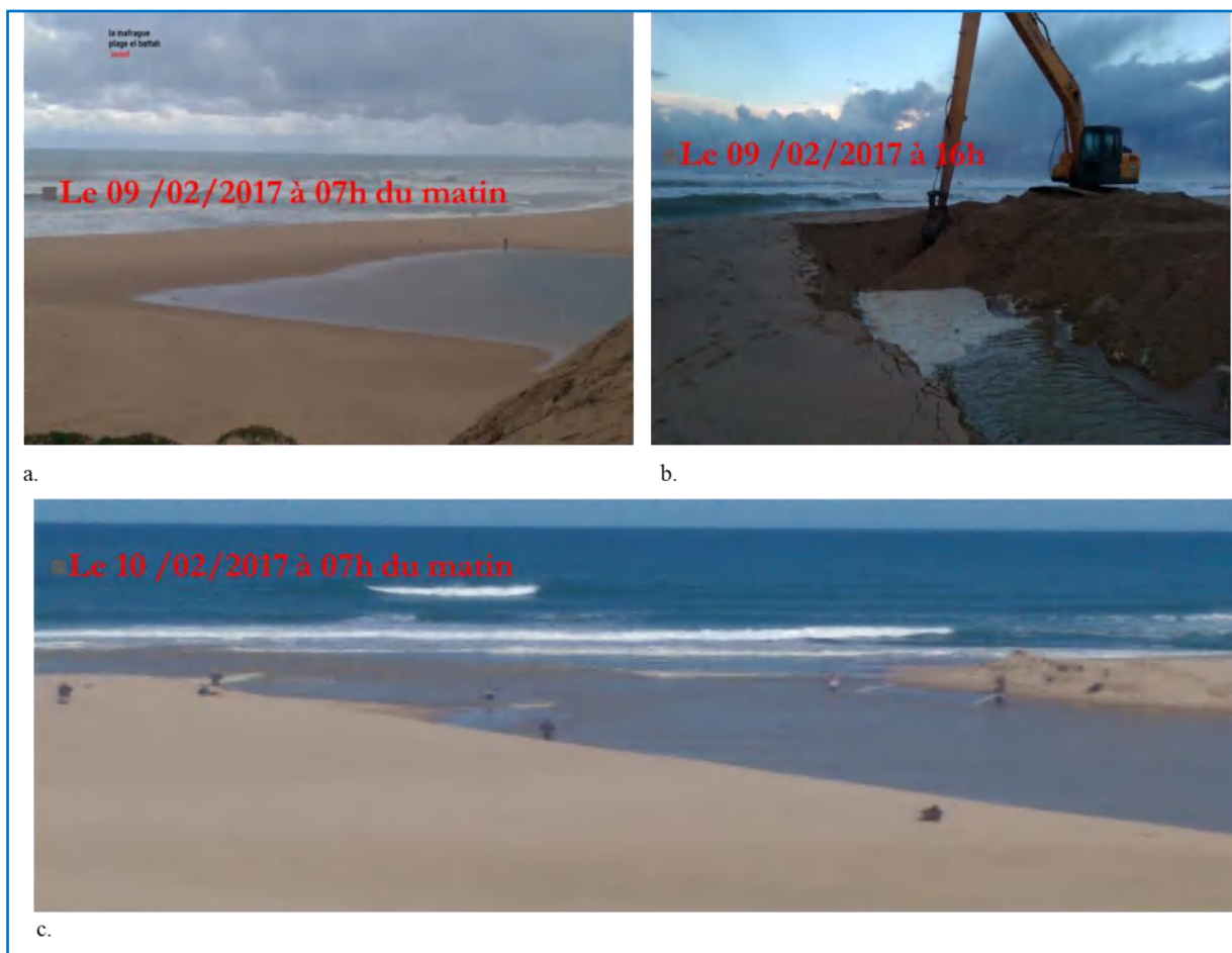
Photo 25 : Curage de la barre sableuse formée au niveau de la Mafragh le 09/02/2017(DRE de la Wilaya d'El Tarf, 2017). a. Formation de la barre sableuse le 09/02/2017 à 7 h du matin.. b. Curage de la barre sableuse le 09/02/2017 à 16 h. c. Ouverture de la barre sableuse le 10//02/2017 à 7 h du matin (plage El Batah)
