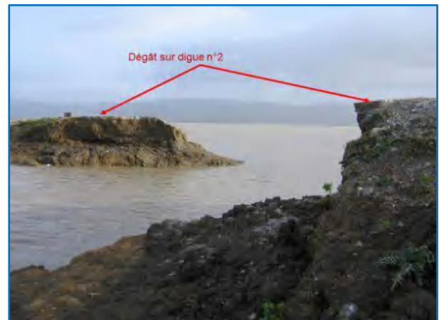
Photo 28: Destruction d'un tronçon de la digue 2 (ONID, 5 mars 2012)
