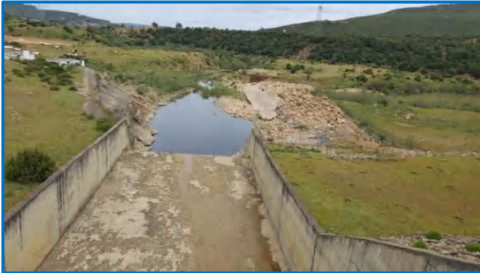
Photo 18: Dégâts de la crue des 22 et 23 février 2012 sur l'évacuateur de crue du barrage de Mexa (Affoun, mai 2017)
