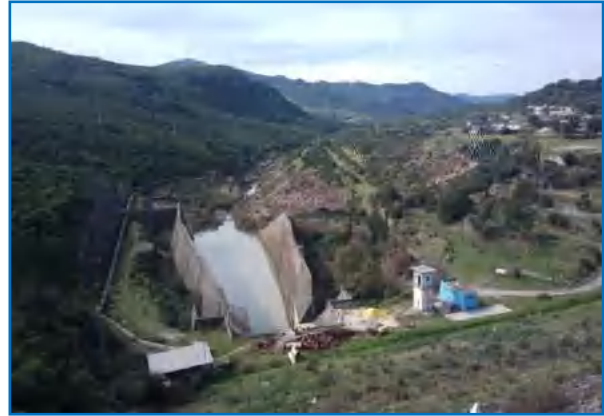
Photo 2 : Bassin de dissipation et conduite de restitution du barrage Cheffia (Affoun, 2018)
