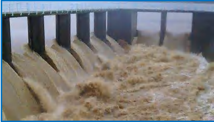
Photo 17: Fonctionnement de l'évacuateur de crue du barrage de Mexa (crue du 16/12/2018) (ANBT, 2018).
