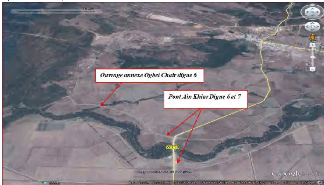
Figure 85. Digue 6 et 7 : les points endommagés ; Pont reliant El Tarf ville et l'agglomération de Ain Khiair (photos 34 et 35). (DRE, 2015).
