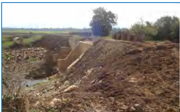
Photo 38: Dégât réparé au niveau de l'ouvrage de l'oued Lahmar (passage sous-digue 4 avec clapet anti-retour. (DRE, 2015).
