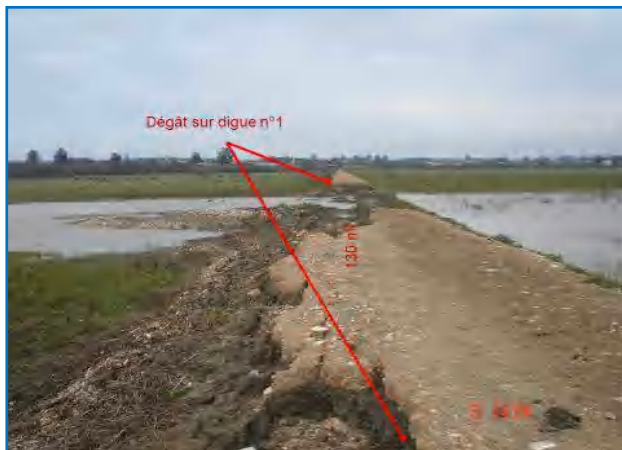
Photo 27: Dégradation de la digue 1 (ONID, 5 mars 2012).
