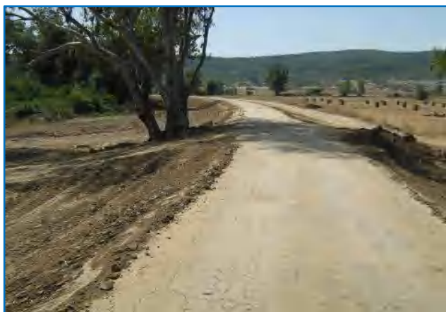
Photo 19: Digue (ouvrage de protection). (ONID El Tarf, 2011)
