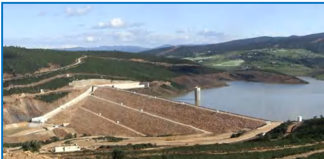
Photo 15: Evacuateur de crue du barrage de Bougous (ANBT ,2011)
