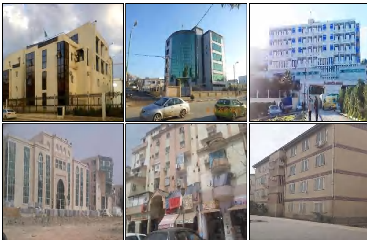
Figure 1.29 : Photo des équipements publics (administratif, sanitaires) et des bâtiments collectifs en béton armée et en charpente métallique.
