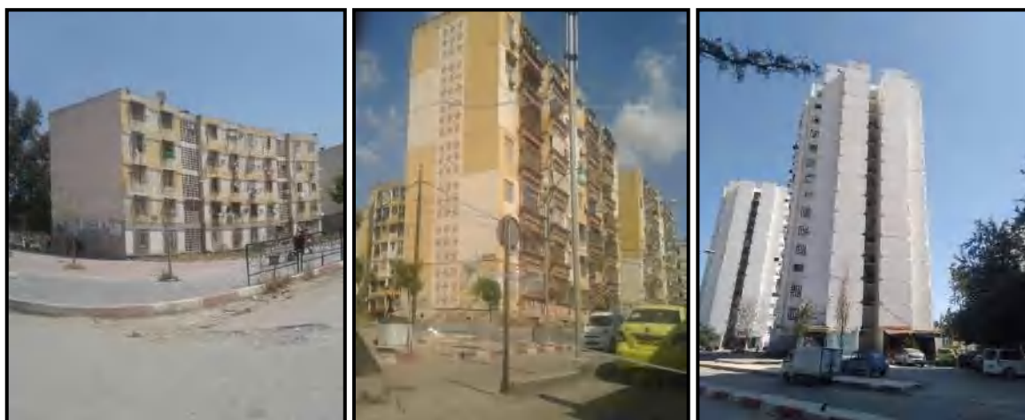
Figure 1.28 : Photos sur les typologies constructives en panneaux préfabriqués des bâtiments collectifs de la zone 3.
