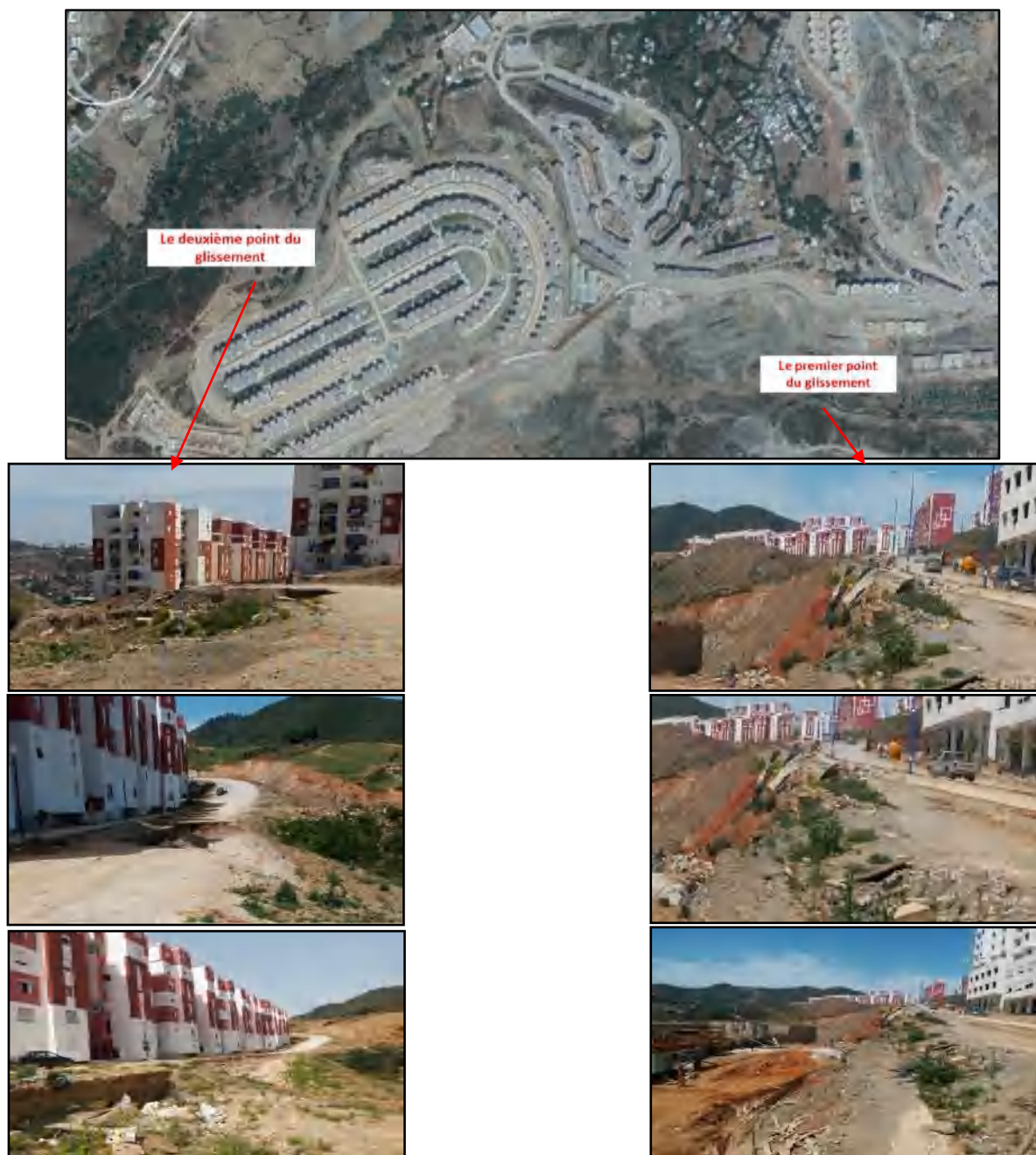
Figure 1.30 : Photos sur les deux points de glissement sur le site de Msiouene près des logements.
