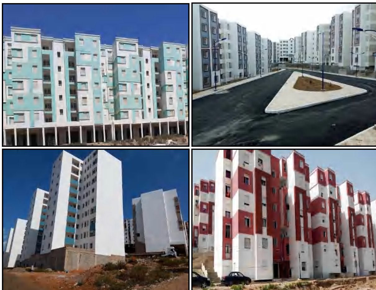
Figure 1.32 : Photo des façades principales des bâtiments collectifs des différents sites (Briquèterie, Zef Zaf, Msîouene et Bouabaz).
