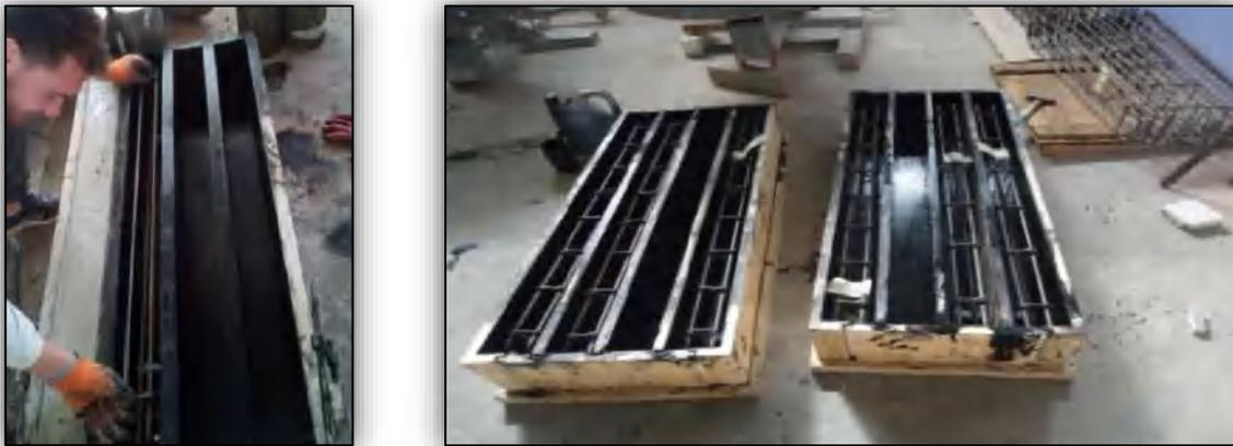
**Figure 5.6.** Pose du ferrailage
