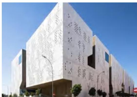
**Figure1.4.** Façade en béton renforcé de fibres verre pour le Palais de justice de Meccano à Cordoue [22]
