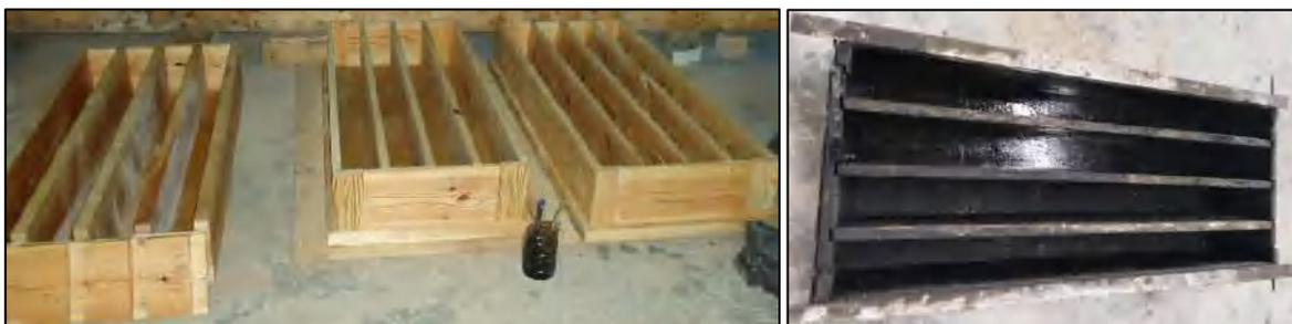
Figure 5.2. Coffrages en bois utilisés pour réalisation des poutres étudiées.
