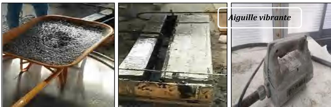
**Figure 5.7.** Coulage des poutres en béton ordinaire témoins
