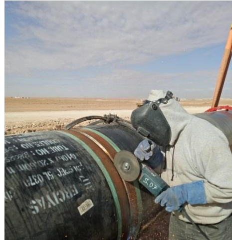
Figure 3- 6:l'opération de chanfreinage pour le soudage automatique et manuel.
