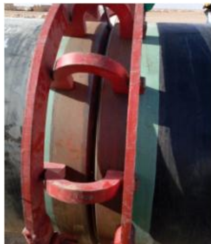
Figure 3- 7:l'opération de Clampsage pour le soudage automatique et manuel.
