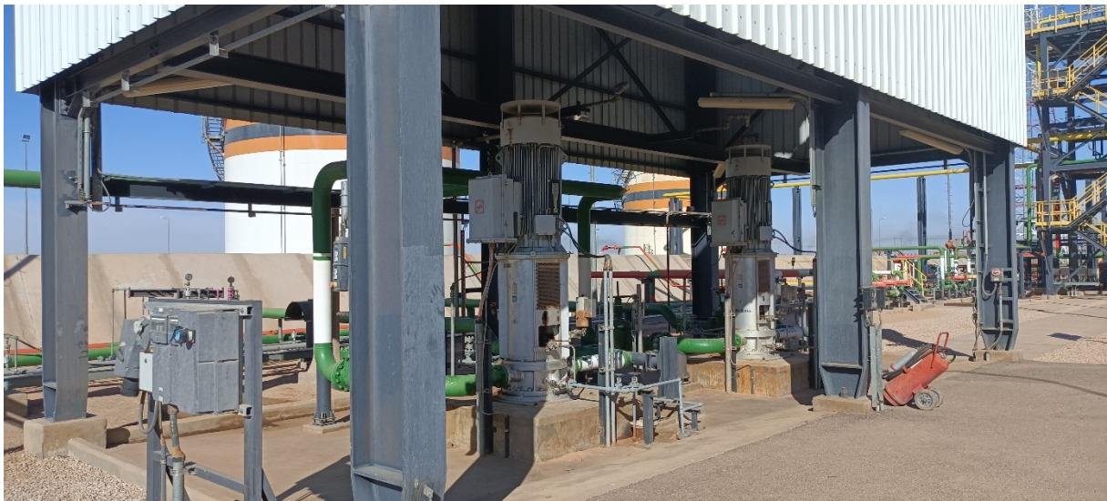
Figure IV. 11: Pompes d'expédition de pétrole traité
