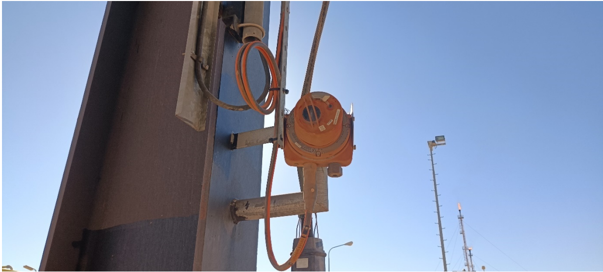
Figure IV. 12: Détecteur de flamme
