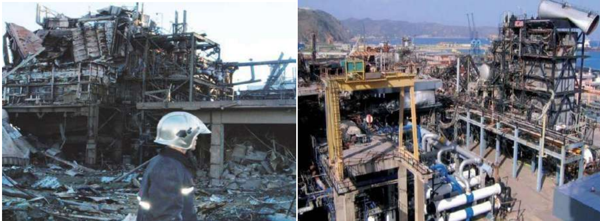
Figure 2.1 : Dégâts causés par l'explosion du GNL de Skikda 19 octobre 2004
