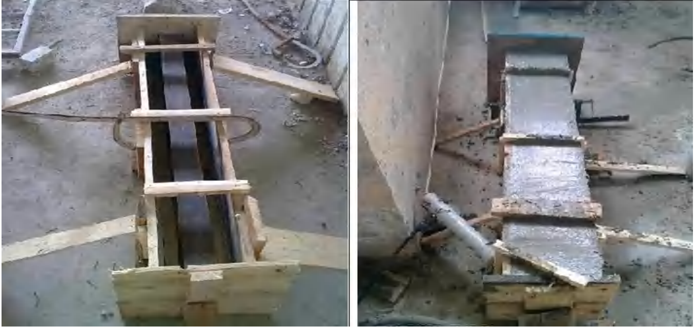
Figure (4-5): Coffrage et bétonnage des poutres mixtes
