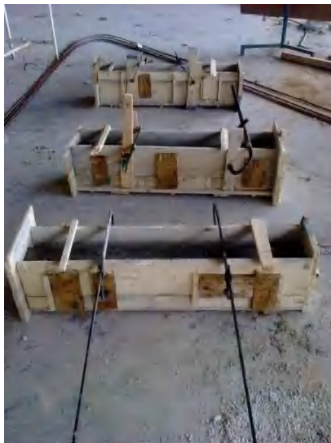
Figure 4.49 : Coffrage poutres
