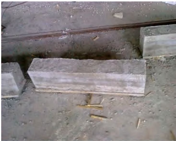
Figure 4.59 : poutres après décoffrage
