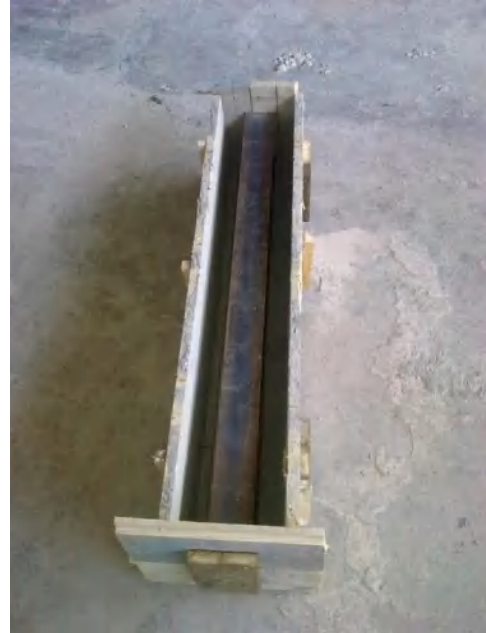
Figure 4.57 : coffrages poutres
