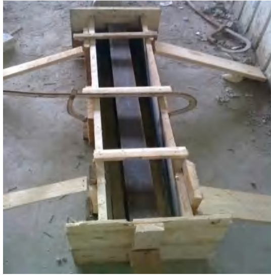
Figure (4-31) coffrage poutre composée
