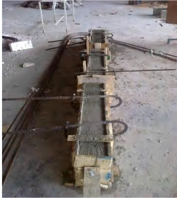
Figure 4.58 : poutres après coulage
