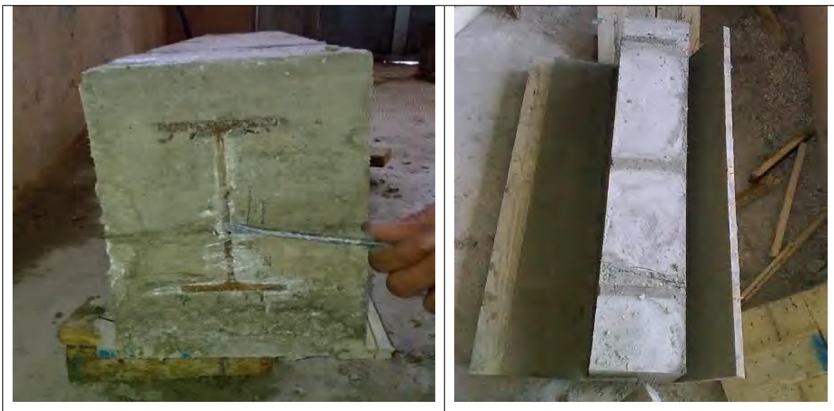
Figure (4-6): Décoffrage des poutres mixtes
