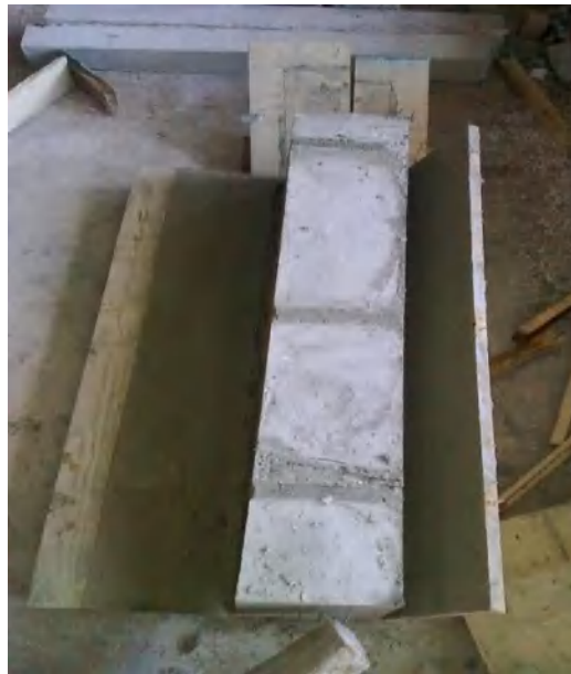
Figure (4-32) décoffrage poutre composée.
