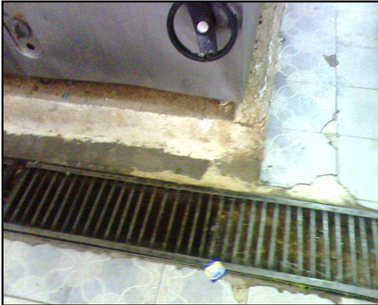
Figure 06 Un segment du sol de la cuisine
