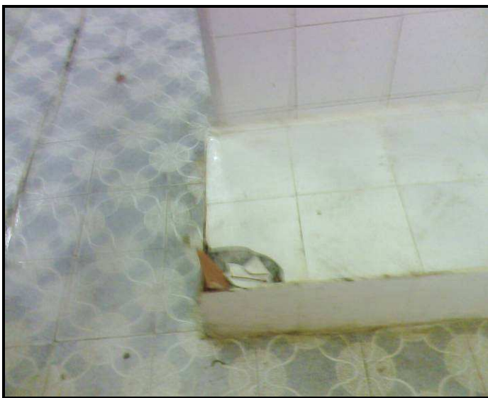
Figure 10 Faillances fissurées
